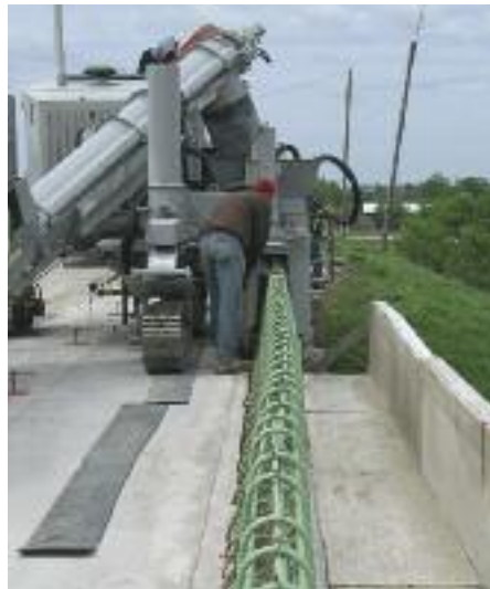
Pouring barrier over rebar cage.
